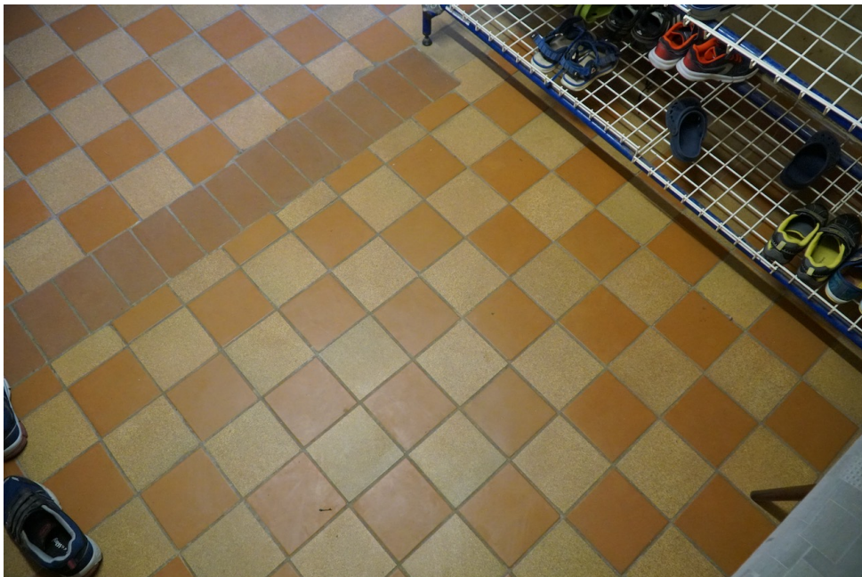
Bodenfliesen im Garderobenbereich
