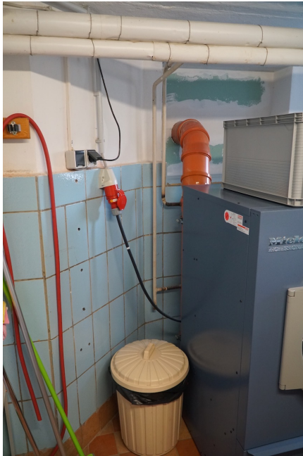
Fliesensockel im Waschhaus
