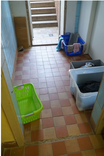
Bodenfliesen im Flurbereich
