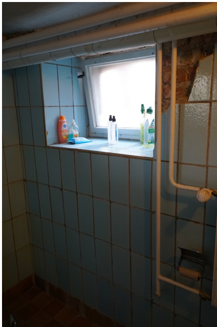
Fenster im Garten-WC
