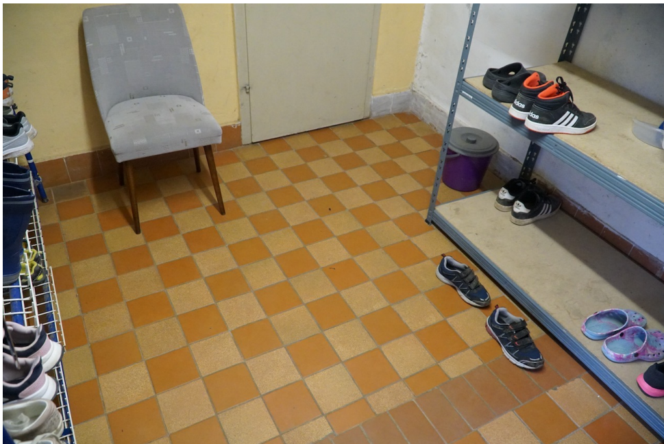
Bodenfliesen im Garderobenbereich
