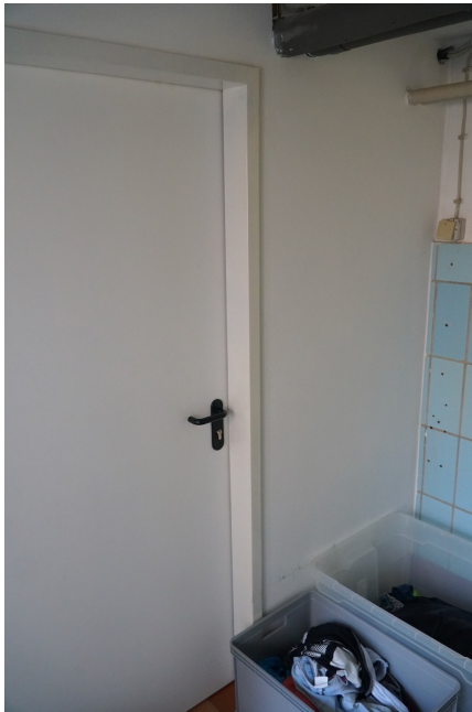
Flurbereich mit Tür zum Waschhaus
